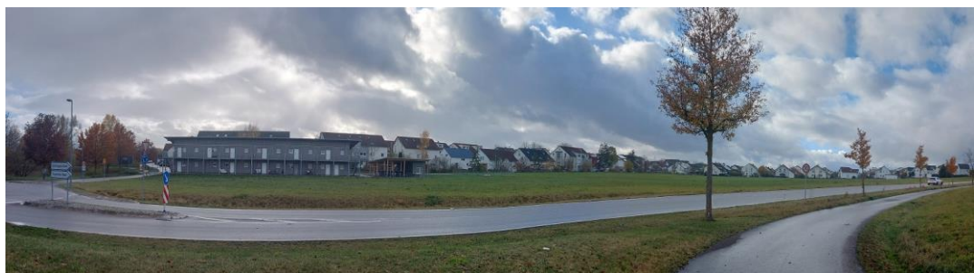
Abbildung 14: Foto, Blick von Nordosten (Baldauf Architekten und Stadtplaner GmbH), 20.11.2023
